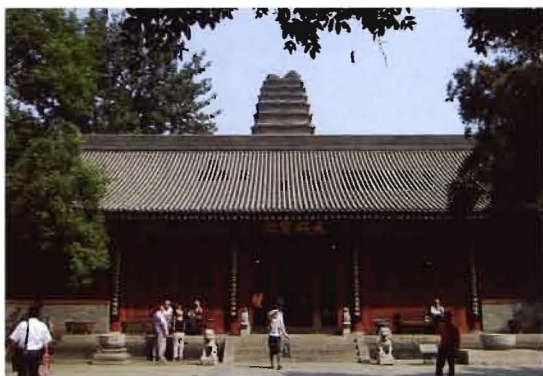
81 小雁塔（本殿の上に見える）
