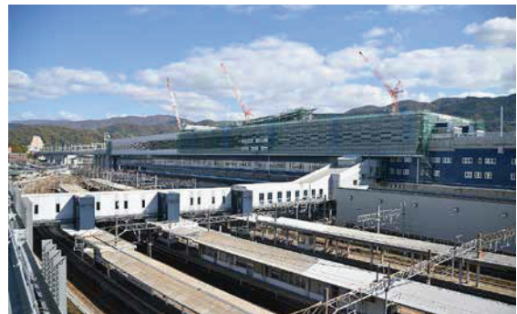
図3 工事が進む敦賀駅 (2022年11月、櫛引撮影)
