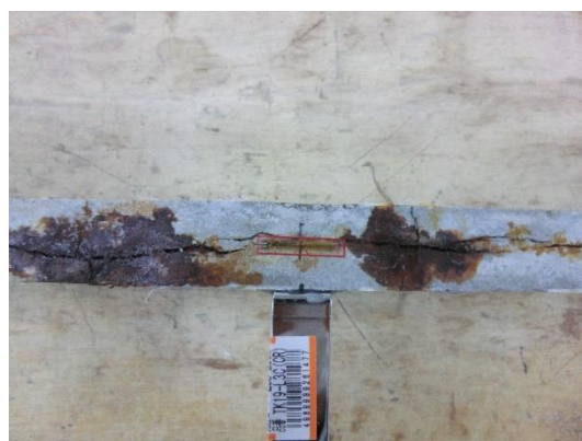
写真 31 : No.2 のひび割れ状況
