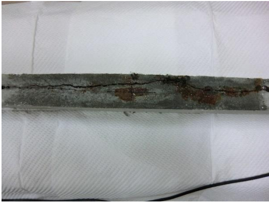
写真 13 : No.3 の腐食ひび割れの様子
