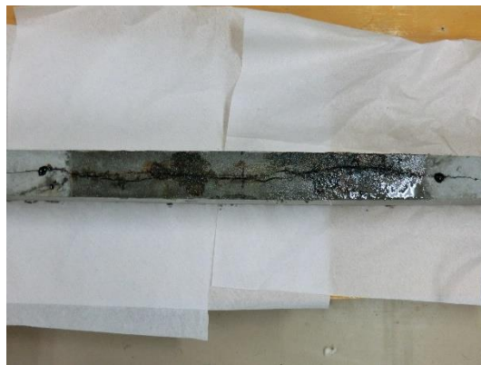
写真 12 : No.2 の腐食ひび割れの様子
