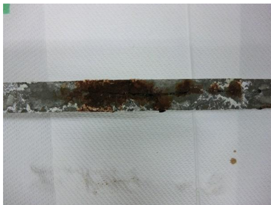
写真 18 : No.VIの腐食ひび割れの様子
