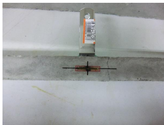
写真 23 : No.①のひび割れ状況
