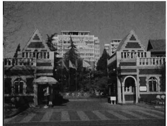
写真14 旧ベルギー公使館 現紫金賓館。
