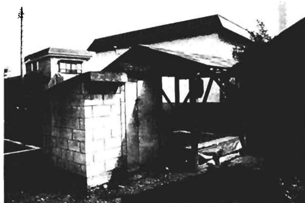
⑪ 小比内船水家の清水（現在は簡易水道）
