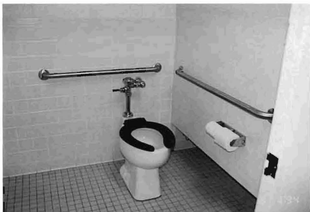
24. 手すりのついたトイレ
