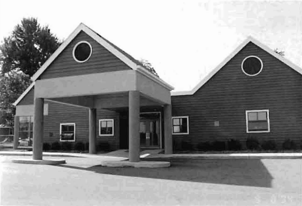
3. UTM チャイルドケアセンター 正面
