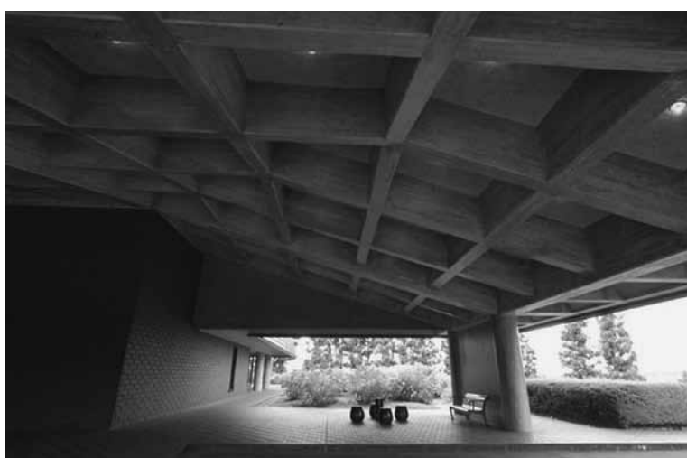
図12 弘前市斎場入口にある巨大な庇。A-haus編集部提供
