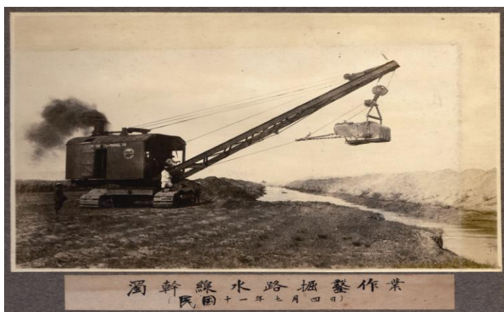
写真-10 記録写真 烏山頭工事で使われた大型土木機械 (提供・嘉南農田水利会)
