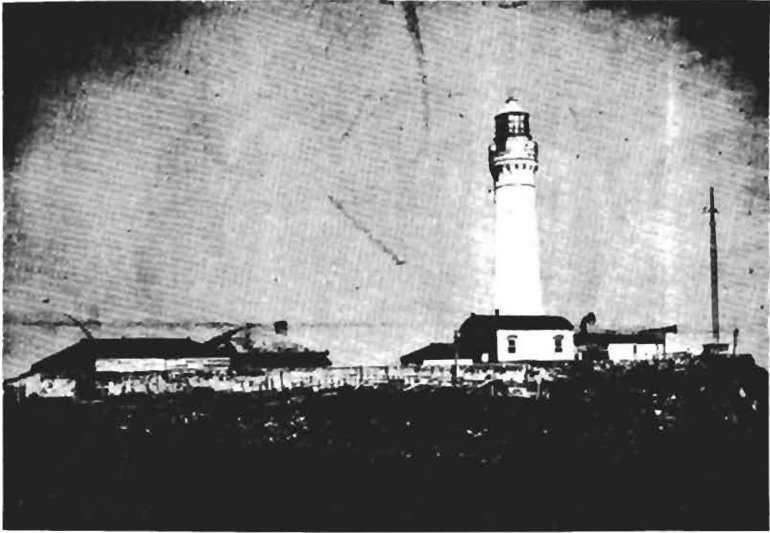
尻矢崎燈臺の全景（大正十三年九月鯨井燈臺長撮影）
