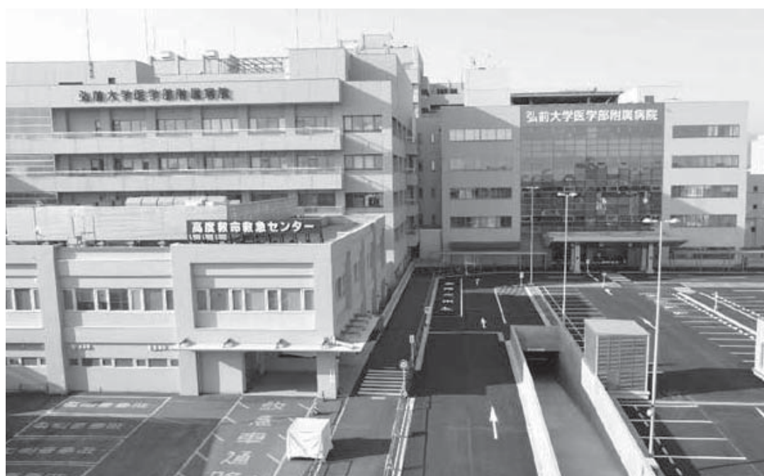
写真5 新設された高度救命救急センター
