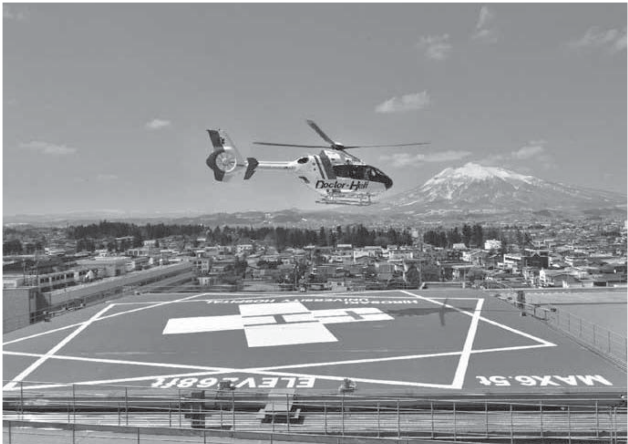
写真1 附属病院屋上のヘリポート
