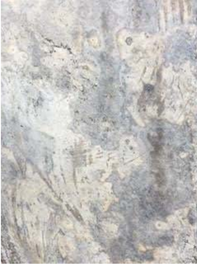
図2. D撮影のセメント塗の壁面
