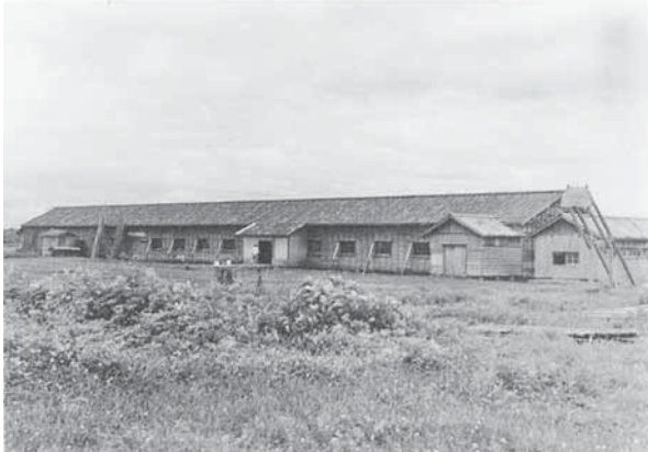
写真1 1955（昭和30）年当時の東鳴沢中学校校舎 （北側から）
