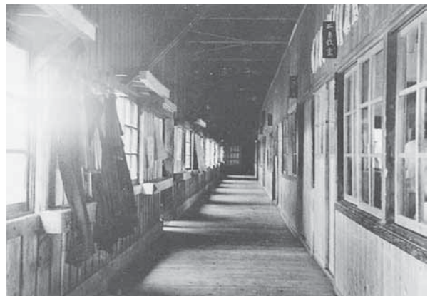
写真3 東鳴沢中学校北側の廊下 窓の横には銃架が残る
