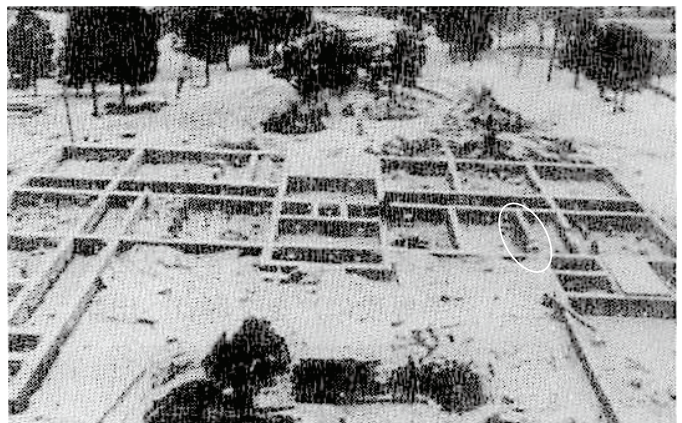
2 昭和42(1967)年解体時基礎（弘前大学農学部同窓会1984） ○印は石材出土範囲に対応する基礎
